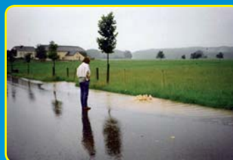
Stark überlasteter Mischwasserkanal
