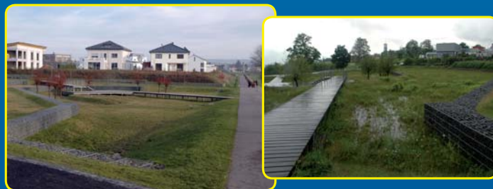
zentrale Versickerung mit Speicherung (in trockenem und gefülltem Zustand)
