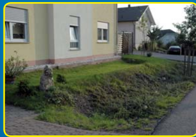
Mulde und straßenbegleitender Graben
