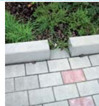
Fugenpflaster mit Überlauf in Grünfläche
