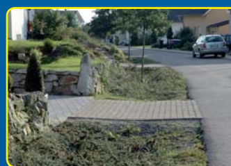
Straßenbegleitender Graben mit Versickerung
