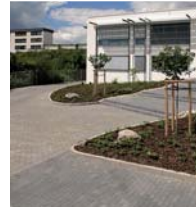
Fugenpflaster mit Überlauf in Grünfläche
