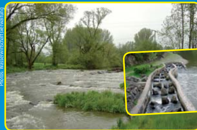
Verbesserung der Fischdurchgängigkeit anhand von Fischtreppen oder Fischrampen
